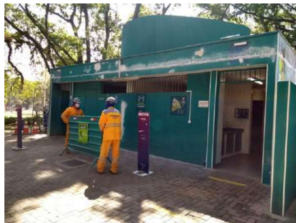
Figura 64: Reforma dos sanitários
