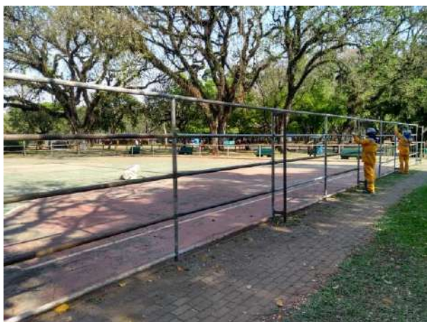
Figura 85: Quadra - Reforma dos Alambrados
