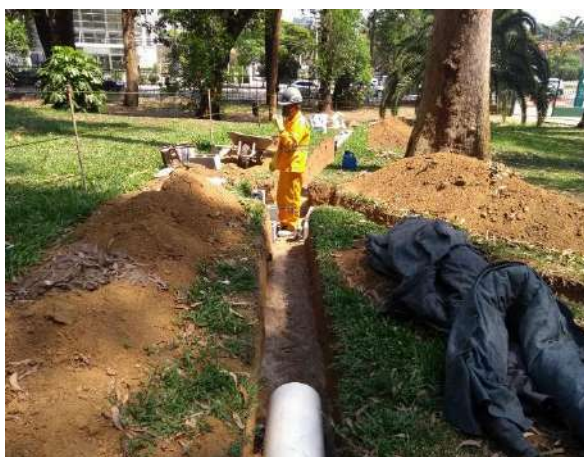
Figura 71: Drenagem Próximo ao P8
