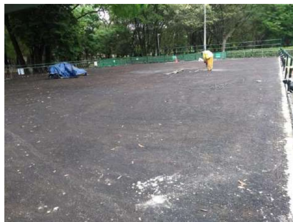
Figura 86: Quadra - Reforma do Piso
