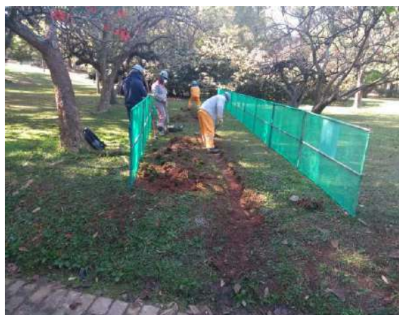
Figura 72: Drenagem Próximo a Ponte de Ferro
