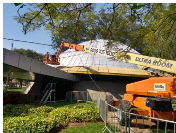
Figura 68: Limpeza da Cúpula
