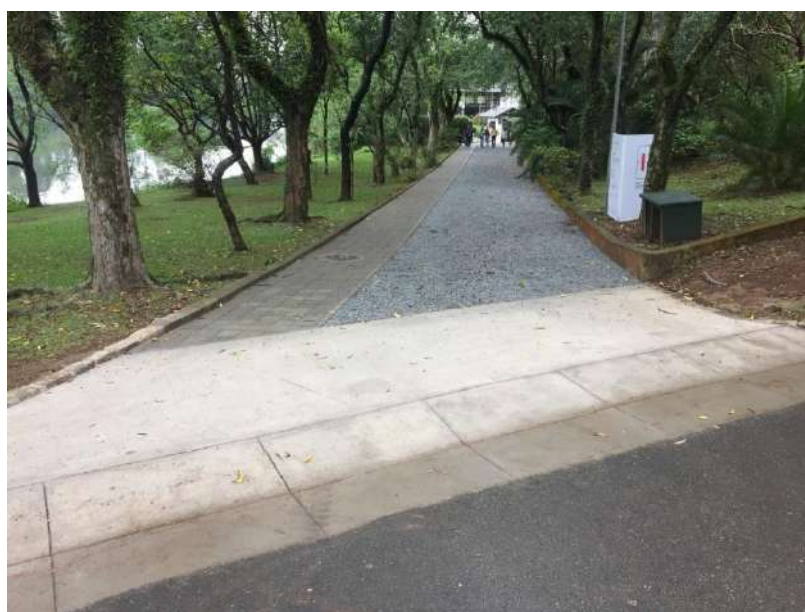
Figura 55: Caminho acessível para o pavilhão Japonês feito com piso permeável
