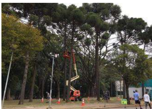
Figura 43. Poda de galhos secos das araucárias próximas ao banheiro 8.
