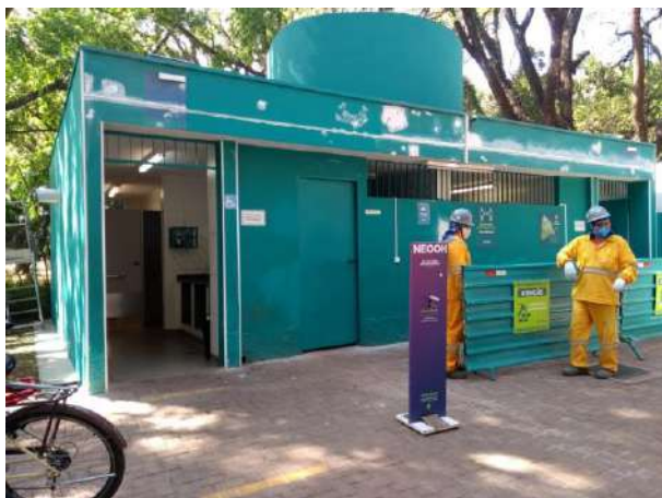
Figura 63: Reforma dos sanitários
